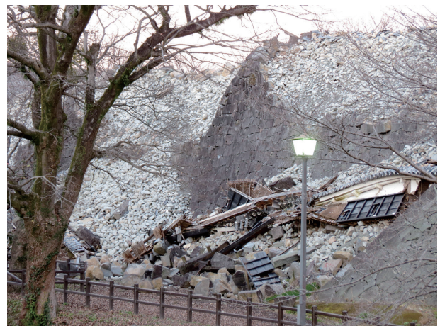
図2 熊本城の壊れた石垣
