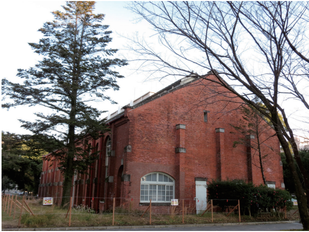
図 3 熊本大学工学部研究資料館（旧熊本高等工業学校機械実験工場）
