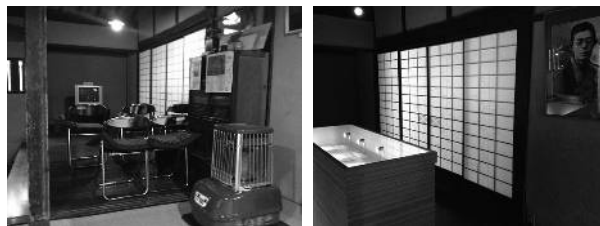
図2：土間に隣接する板の間（左：改修前、右：改修後）
